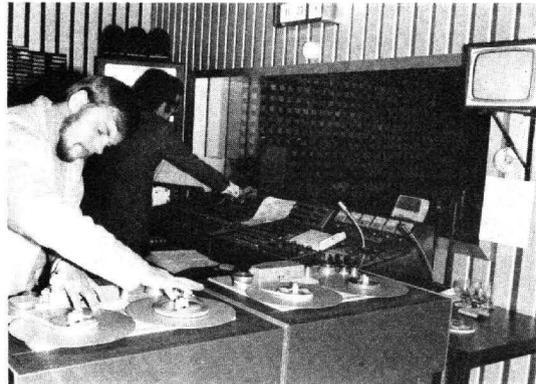
*Les publicités ne passent pas directement sur l'antenne; on voit ici un technicien mettant au point de départ une bande qu'il vient d'enregistrer et qui passera dans quelques minutes. Ces enregistrements sont faits pendant que les animateurs ont l'antenne.*
