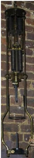
Lampes à arc de la première génération (tiges de carbone se faisant face)
