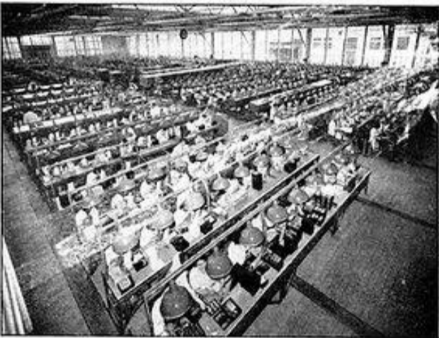
Si on voit l'atelier de montage des tubes, où travaillent environ 400 personnes. Cet atelier occupe la partie centrale du hall entièrement achevé de la photographie ci-dessus. Le montage s'effectue sur un banc à l'aide d'outils individuels qui facilitent la tâche de l'ouvrier et rendent les accès qu'elle a d'exercer un contact direct sur les pièces.
