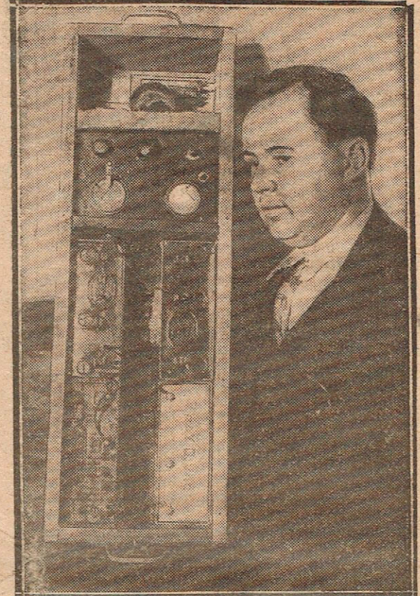
Cette boîte représente un système d'alarme automatique contre les cambrioleurs qui est basé sur les propriétés des cellules photo-électriques. L'ombre d'un voleur passant devant l'appareil suffit pour le déclencher.
