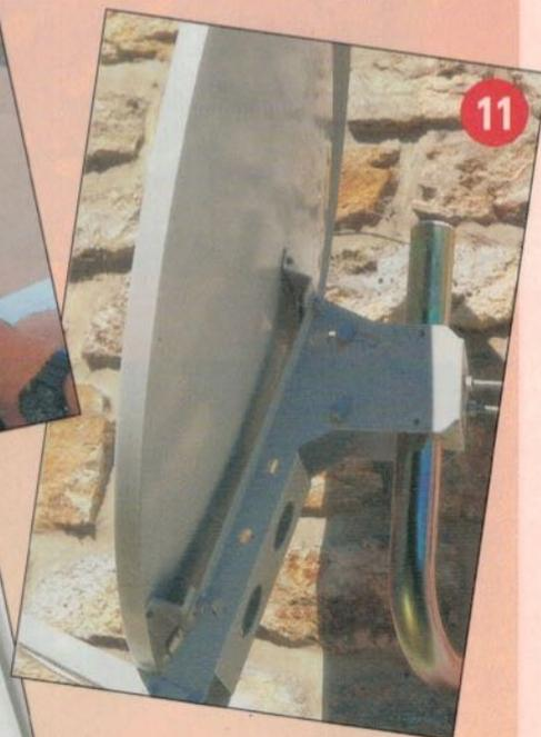
**11** Quatre boulons suffisent à assembler antenne et support, on commence par ceux du bas, on enfle l'antenne (les trous sont ouverts) et on termine par les boulons du haut.
