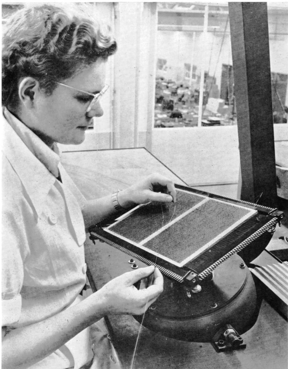
Tissage d'une matrice de mémoire à noyaux magnétiques (L'opératrice procède à l'insertion du fil de lecture)
