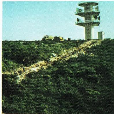
Pose de câble coaxial d'amorce de faisceaux hertziens
