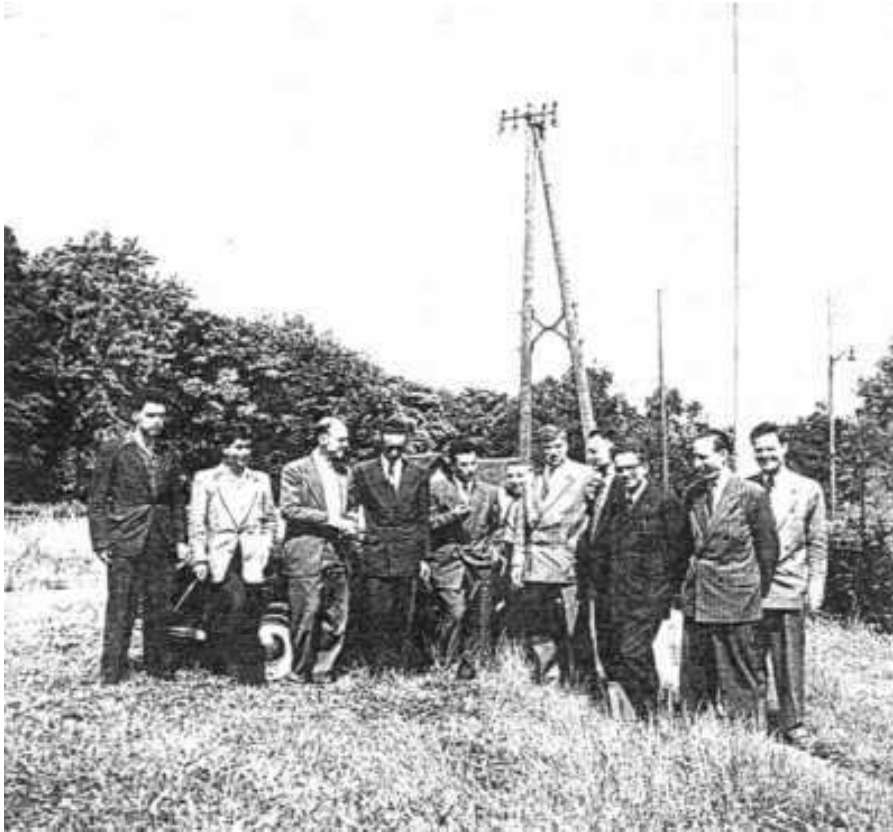
L'équipe du département G chargée des faisceaux hertziens CORMEILLES en PARISIS de gauche à droite PASSE, FESSARD (tech.), J. C. SIMON, V. BIGGI, Ph. MAGNE, WATSON (tech) H. GUTTON, D. GROBOIS, J. FAGOT, J. HUGON, P. BRAILLARD (remarquer un vestige : le poteau télégraphique)
