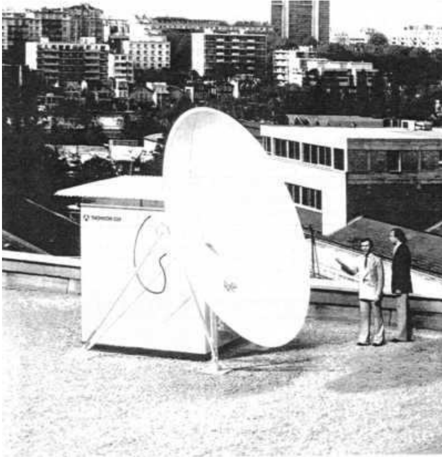
Présentation générale de la station (sous-ensemble radio-électrique)
