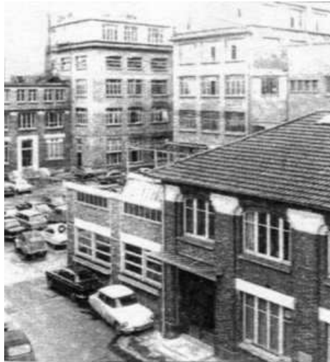
L'usine Henri CHIREIX qui abrita, pendant de nombreuses années, la Divisio, Faisceaux Hertziens et Liaisons Spatiales de THOMSON CSF
