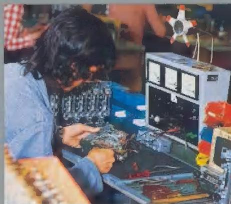
Erst nach exakter Kontrolle kommen die Einzelteile zur Bandmontage mit elektronischer Endkontrolle. Diese Elektronik ist weitaus kritischer als das empfindlichste menschliche Ohr. Erst wenn alle Meßzeiger bis „optimal“ ausschlagen, gilt ein BECKER-Autoradio als „gut“ für den Verkauf.
