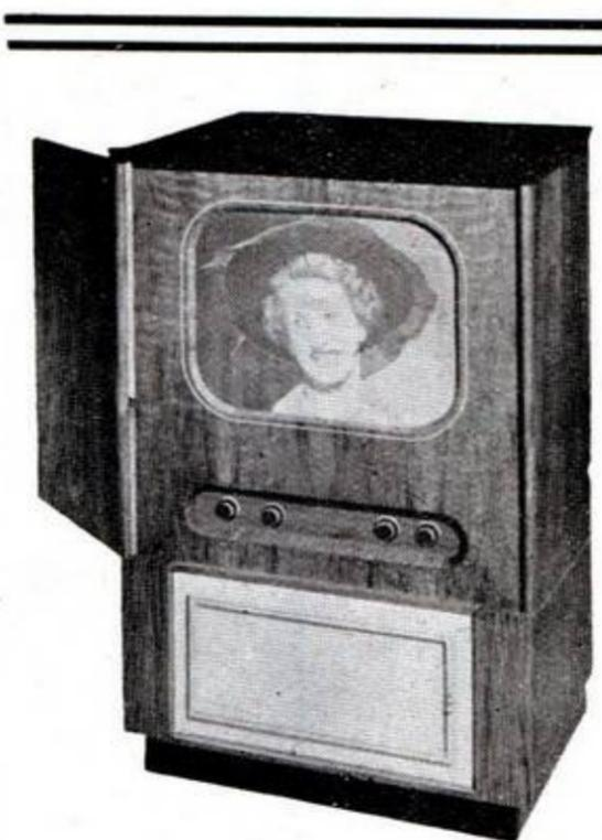
Téléviseur Philips à projection, image de 58 cm de diagonale.
