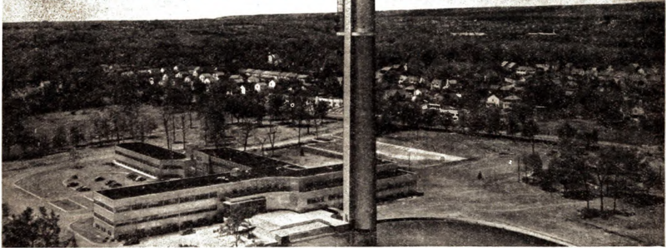
Tour installée à Nutley (N.J.) par "Federal Telecommunication Laboratories" pour expérimenter les liaisons par câble hertzien.
