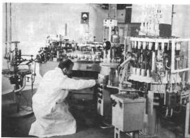
**Figure 84.** Un technicien met en œuvre une machine Sealex, transfert circulaire entièrement automatisé. Les pompes à vide sont situées dans la cabine en tôle insonorisée visible à l'arrière plan à droite. Une fois le processus stabilisé, ce qui pouvait demander plusieurs jours et des centaines de tubes ratés, la production était ininterrompue pendant des semaines entières, et des lots de plusieurs milliers de tubes quasiment identiques pouvaient ainsi être produits.
