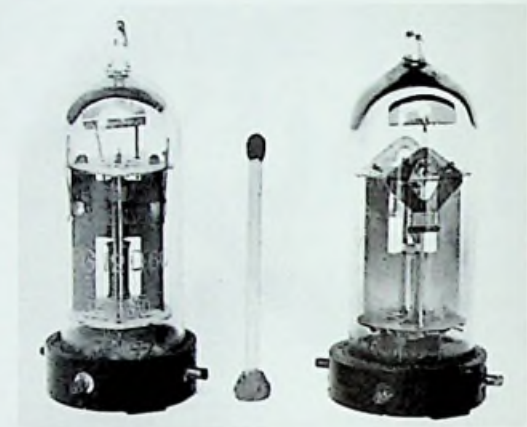
TeKaDe type RG12D60 rectifiers (1939).
