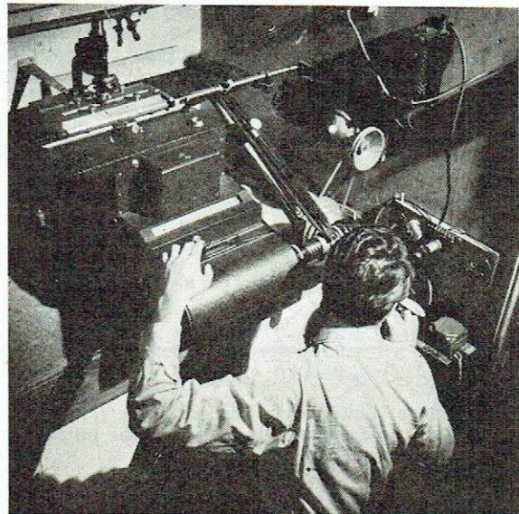
Fig. 1. — Microdensitomètre photoélectrique. (Photo Jean Vividé.)
