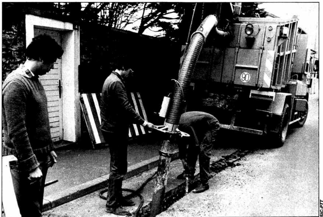
Pose de câbles à Biarritz : dans le coût total d'un réseau câblé, les travaux de génie civil sont très importants.
