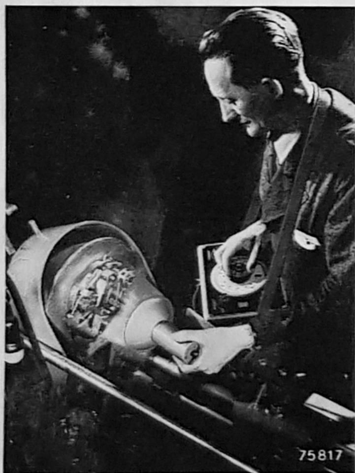
Fig. 2. Observation stroboscopique sur une machine à bobiner pour grilles de tubes électroniques
