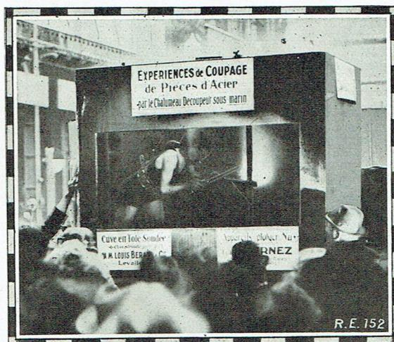
Fig. 17. — Une expérience curieuse : le plongeur descendu dans la cuve découpe dans l'eau une plaque de blindage très épaisse au moyen du chalumeau oxyacétylénique.
