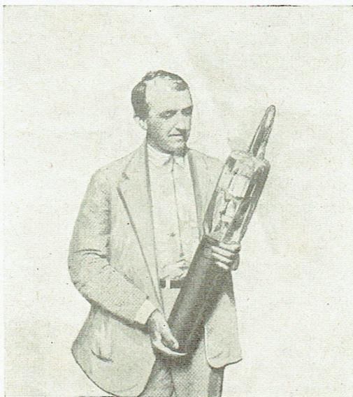
que l'on a pu enfin réussir à sceller *efficacement* le métal au verre. Cette question était en somme jusqu'ici la pierre d'achoppement de la réalisation des tubes à vide de grande puissance. Les scellements réalisés supportent des variations de température
