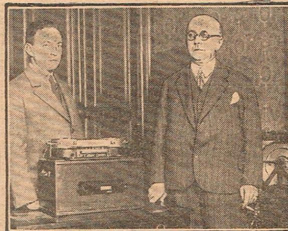
Un savant allemand, le Dr Stille, a inventé et mis au point un appareil auquel il travaille depuis 23 ans, qui permet d'enregistrer magnétiquement les ondes sonores et de les conserver indéfiniment. Le « Mnemophone », tel est son nom, est une application du principe des taches magnétiques découvertes par le savant suédois Poulsen, et dont nous reparlerons prochainement.
